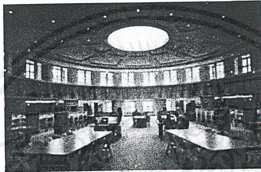
รูปภาพ2 ภายในห้องอ่านหนังสือชั้นสอง เพดาน dry wall และจัดวางวัสดุเก็บเสียง พื้นพรม การใช้แสงสว่างผสมผสานระหว่าง florescent กับ metal halide
