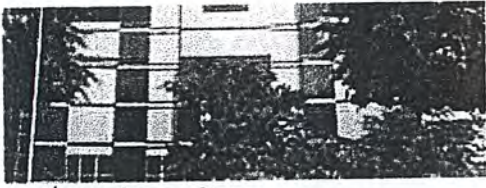
รูปที่ 19 ด้านหน้าของอาคาร
