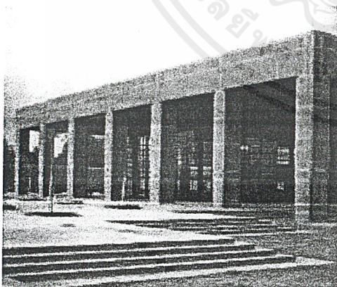
ลักษณะภายนอกอาคาร
