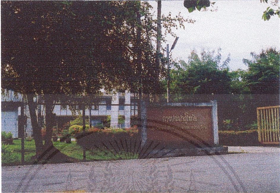
ภาพที่ 3.15 สถานีจ่ายน้ำเมืองเก่า
