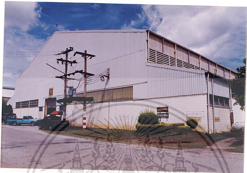
ภาพที่ 5-11 แสดงภายนอกของโรงเก็บและซ่อมบำรุงเครื่องบิน
