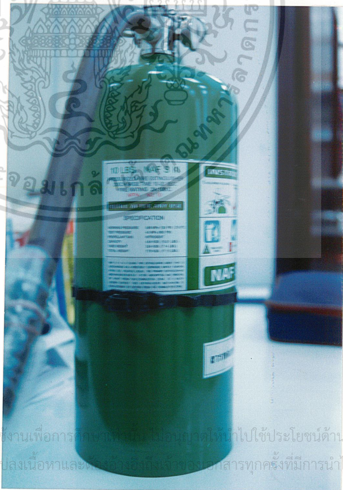
ภาพที่ 5-24 แสดงถังก๊าซไนโตรเจน (NAFS III) ใช้สำหรับ ดับเพลิง
