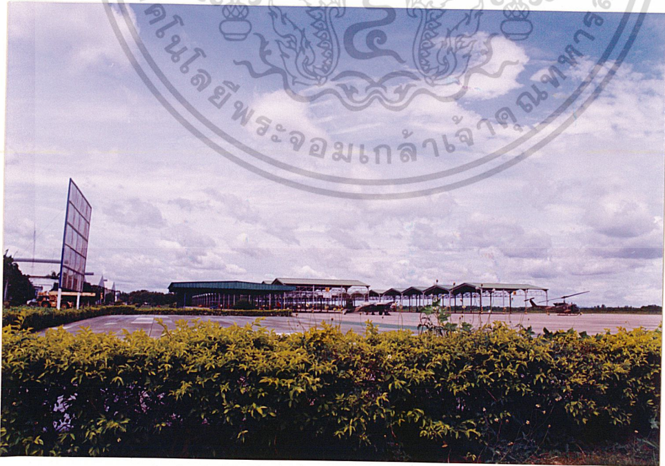
ภาพที่ 5-14 แสดง RUNWAY และโรงจอดเครื่องบิน
