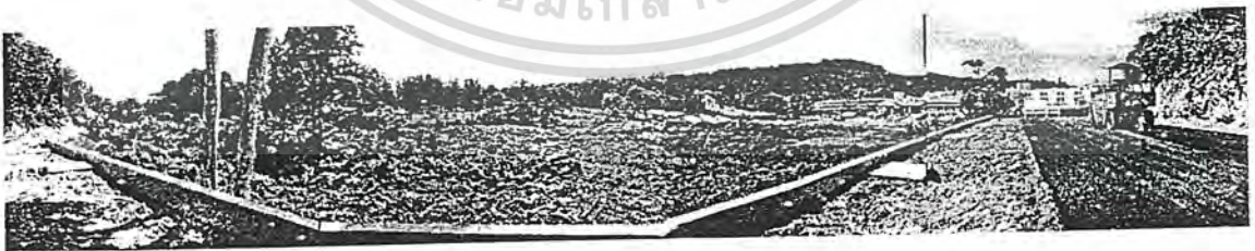
รูปที่ 3-14 แสดงที่ตั้งโครงการด้านทิศตะวันตก
