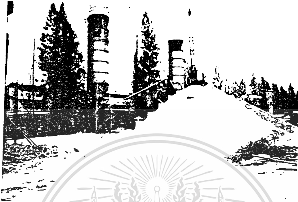
รูปที่ 7.3.1 แสดงบริเวณโรงงาน Ready Mix Concrete
