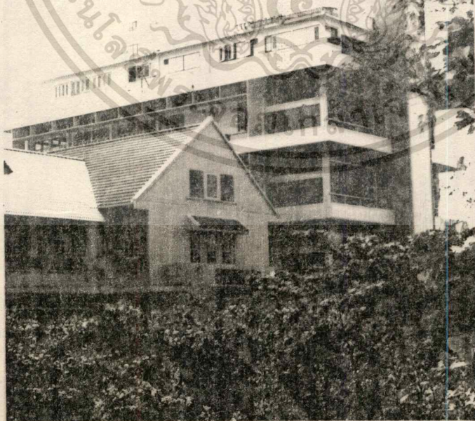
รูปที่ ๒.๗ อาคารภาควิชาวิศวกรรมไฟฟ้า (อาคาร กั้นหลัง)
