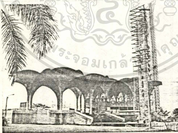
รูปที่ 12.2 อาคารมัสยิดค้ำหน้า ในภาพกำลังก่อสร้าง หอคอยสูง 45 เมตร
