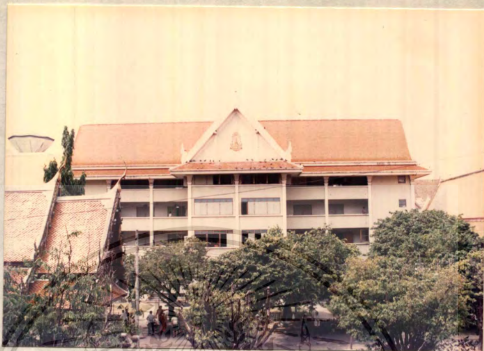
อาคารอำนวยการ
