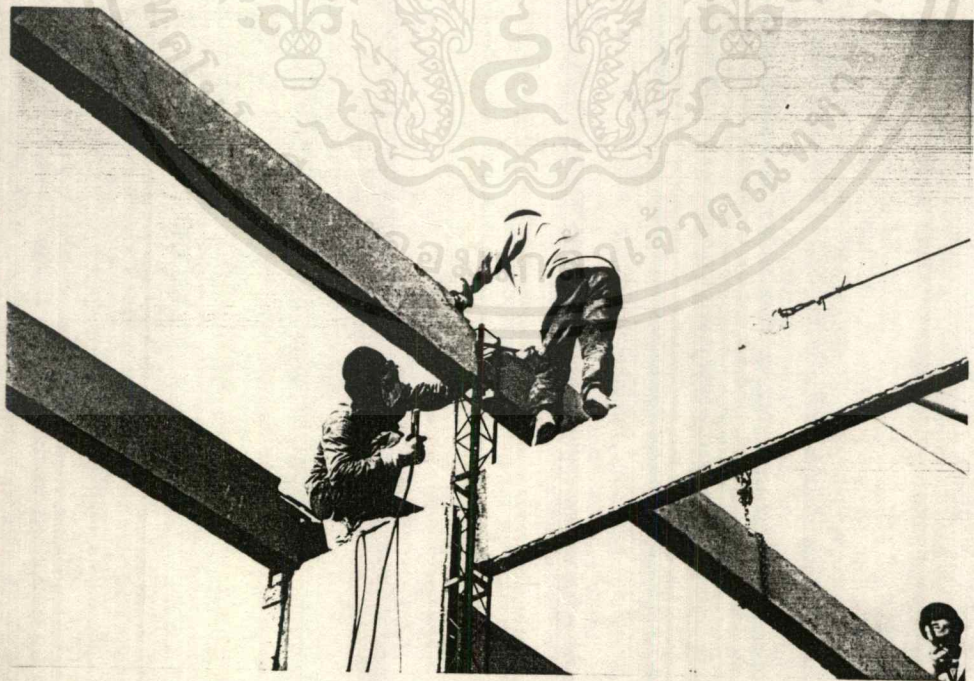
รูปที่ 2.10 การเชื่อมเหล็กคานให้ต่อเนื่อง
