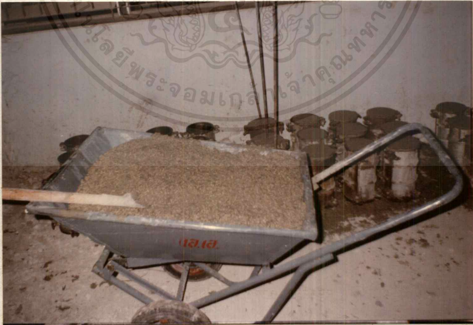
รูปที่ 36 คอนกรีตผสมเสร็จใหม่ ๆ ก่อนการเทคอนกรีตลงแบบ
