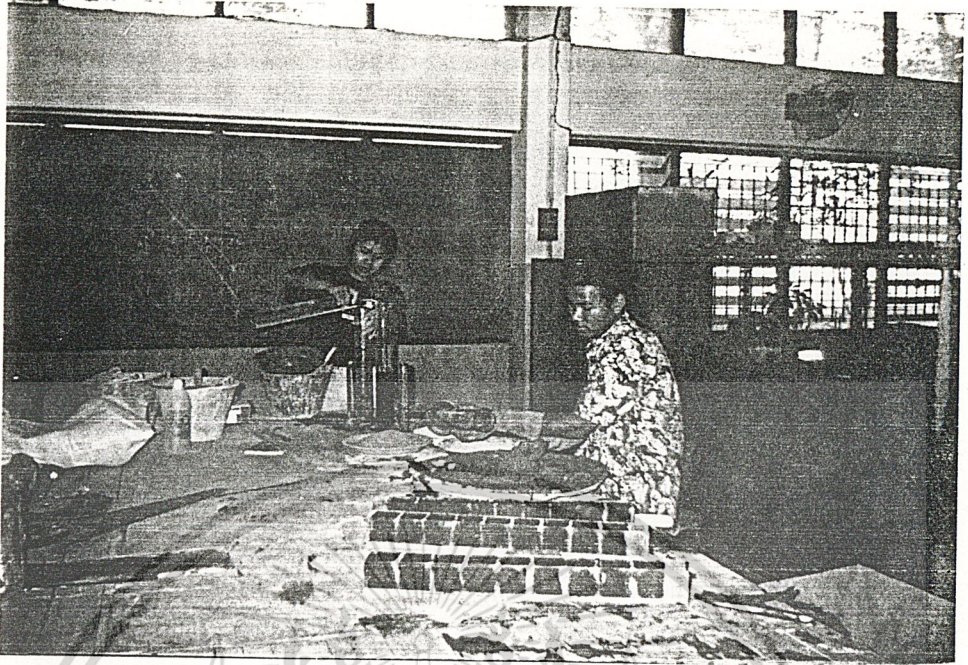
รูปที่ 18 การเตรียมซีเมนต์มอร์ตาร์ในอัตราส่วนต่าง ๆ เพื่อทดสอบหากลังรับแรงอัด
