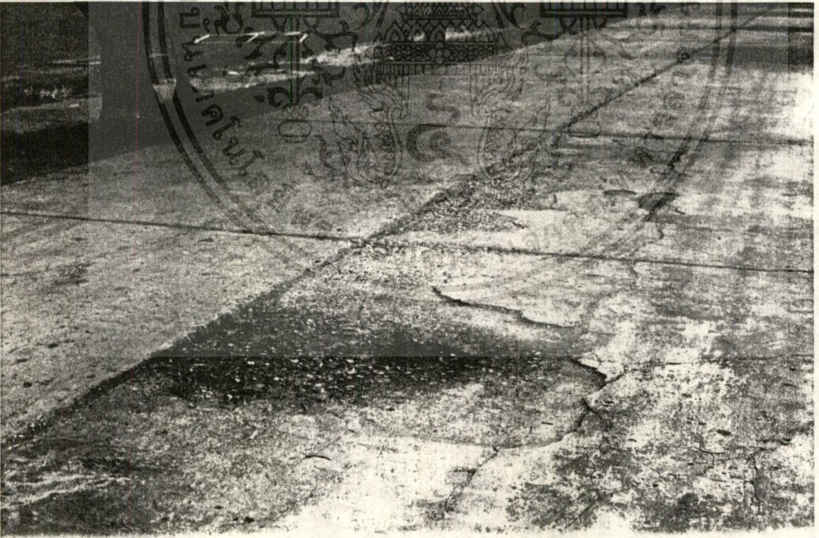
เอกสารนี้เป็นเอกสารที่สงวนไว้สำหรับการใช้งานเพื่อการศึกษาเท่านั้น ไม่อนุญาตให้นำไปใช้ประโยชน์ด้านการค้า รูปที่ 4.7 และ 4.8 ผิวหน้าคอนกรีตหลุดร่อน มีหินโผล่ออกบนผิวทาง (Scaling) ที่มีการนำไปใช้ ไม่ว่ากรณีใดๆ ทั้งสิ้น อีกทั้งห้ามเผยแพร่แบบสิ่งเขียนที่และต้องขังของสิ่งของเอกสารทุกสิ่งที่มีกรนำไปใช้
