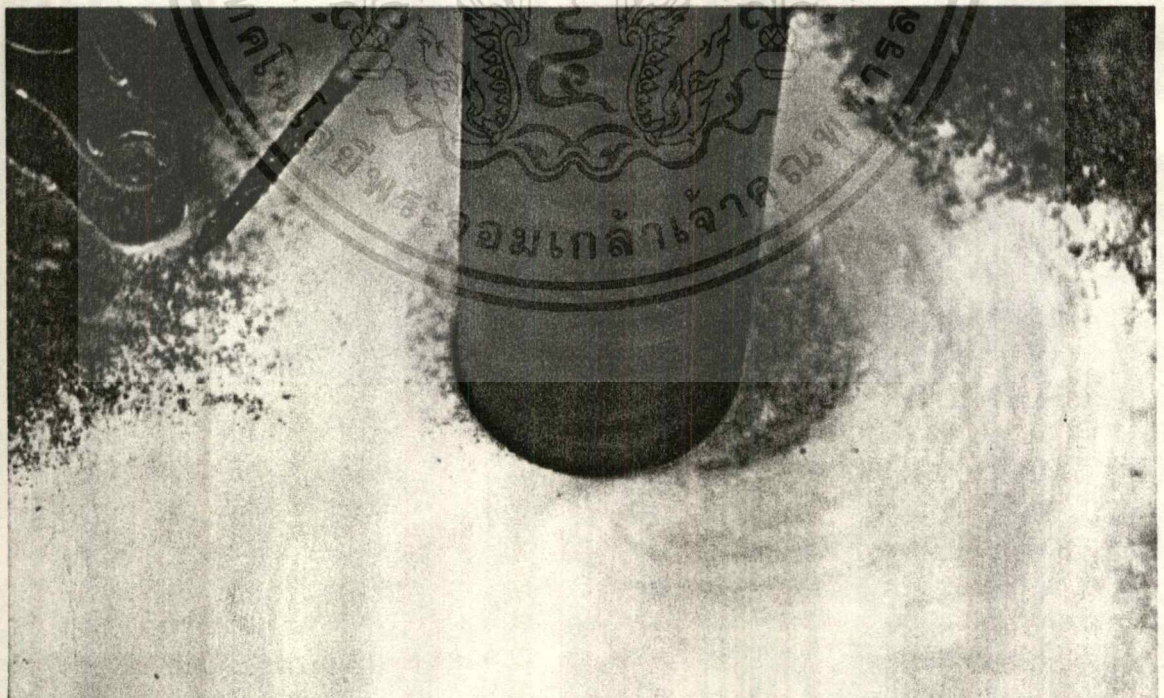
เอกสารนี้เป็นเอกสารที่สงวนไว้สำหรับการใช้งานเพื่อการศึกษาเท่านั้น ไม่อนุญาตให้นำไปใช้ประโยชน์ด้านการค้า ไม่ว่ากรณีใดๆ ทั้งสิ้น อีกทั้งห้ามมิให้ตัดแปลงเนื้อหาและต้องอ้างอิงถึงเจ้าของเอกสารทุกครั้งที่มีการนำไปใช้ รูปที่ 3.6 และ 3.7 แสดงการเจาะถนน (Coring)
