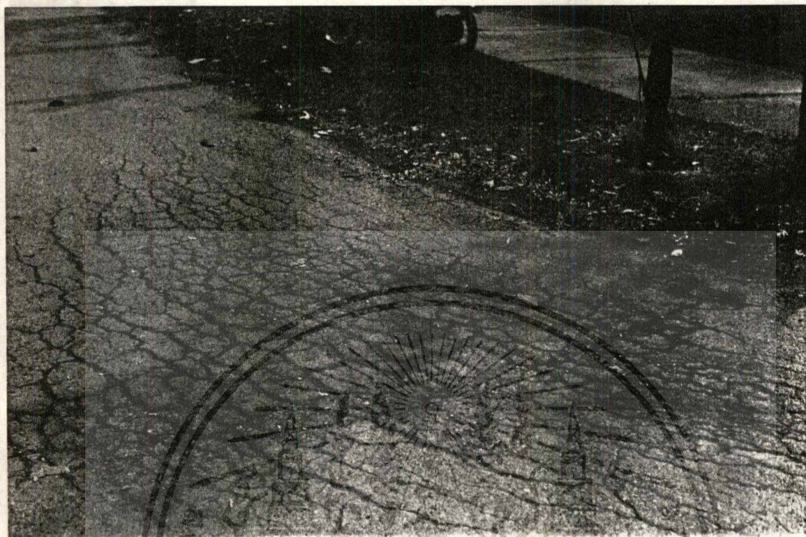
รูปที่ 4.4 ผิวทางแตกเป็นลายแห้วและรอยแตก
