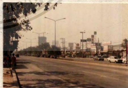
5. ถนนรัชดาภิเษกทางด้านหน้าของ ที่ตั้งโครงการ เป็นเส้นทางไปยังสี่แยก ถนนรัชดาฯ ตัดกับถนนพระราม 9
