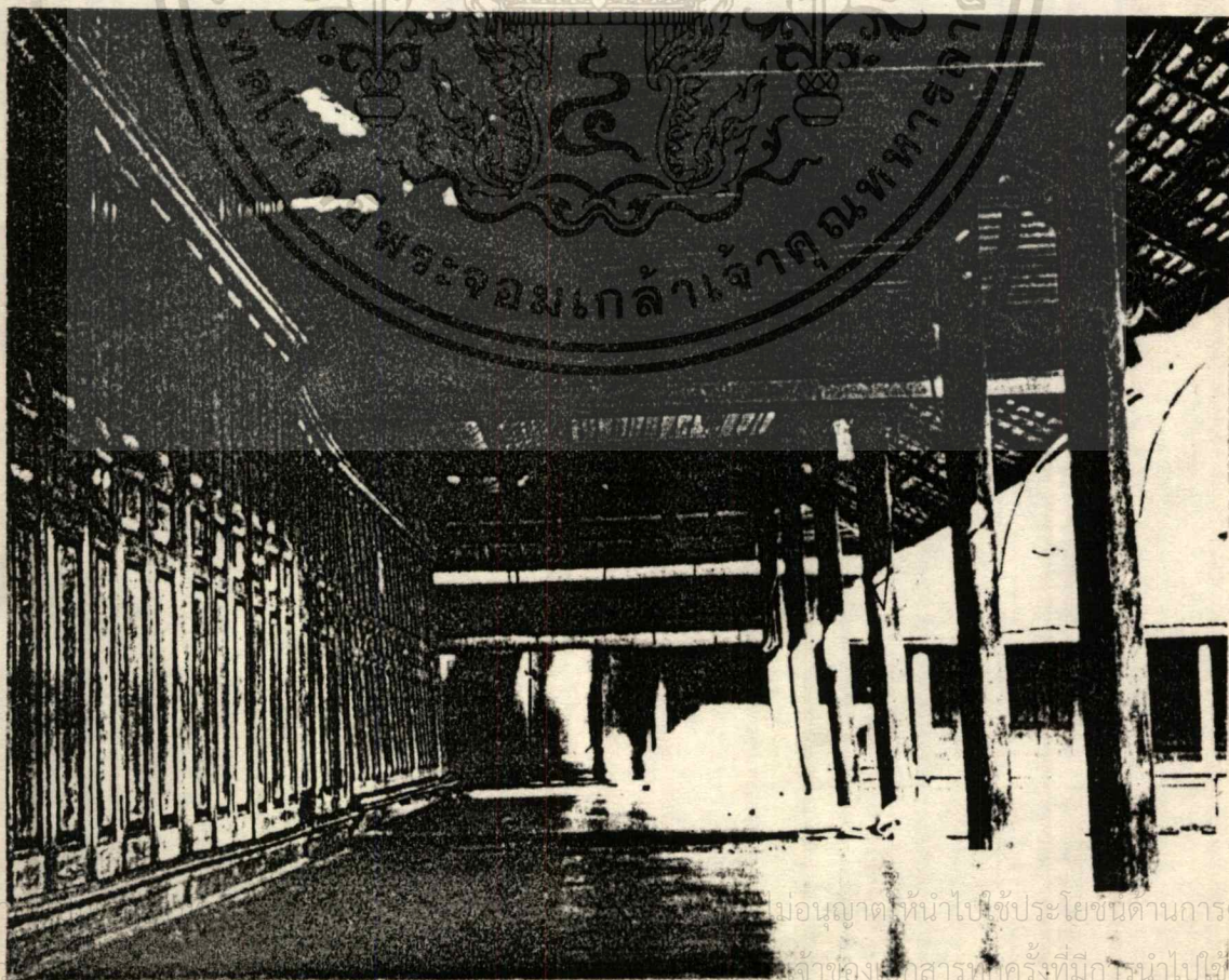
รูปที่ ผ.14 ค้ำในของพาไลที่ยื่น เข้ามาในชานแล่นของ เรือนไทยในกลุ่มกุฎิสงฆ์ วัดเกาะ เพชรบุรี เพราะพาไลกว้างมาก จึงทำหลังคาพิเศษสำหรับพาไลโดยตรง เรียก ว่า เรือนพาไล
