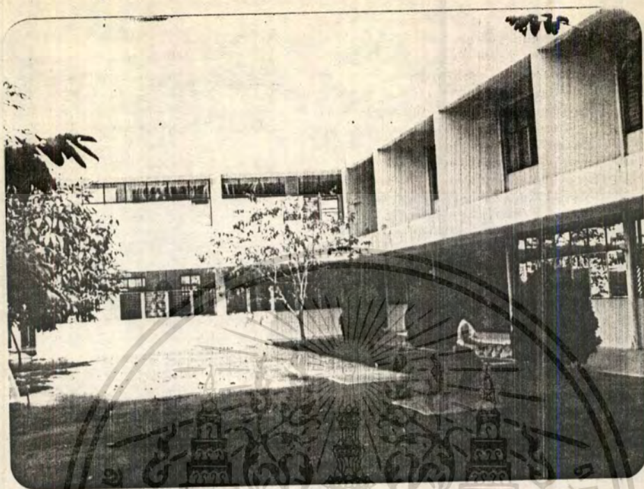
รูปที่ 26 แสดงรูปคานหน้าของอาคารเรียน-หอนอน
