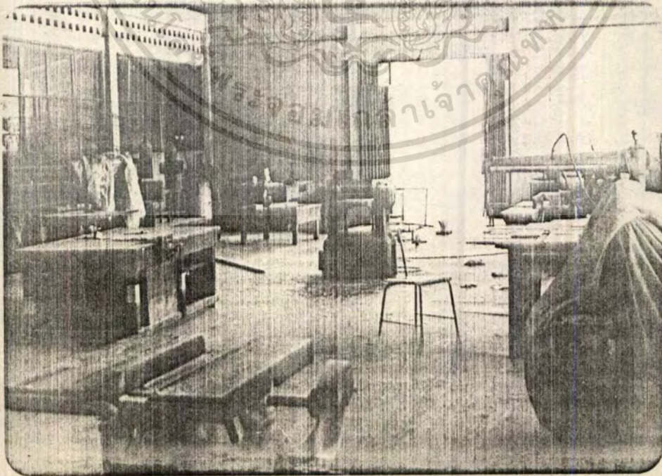
รูปที่ 20 โรงฝึกงานช่างไม้ (โดยใช้เครื่องจักร) ปัจจุบันเลิกใช้แล้ว ในภาพจะเห็นว่าคูกรูกรังมาก
