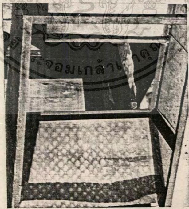
รูปที่ 11 แสดง - ใช้สังกะสีสำหรับหุ้มคู่อทำให้เกิดการบิ่นงอและมีอายุการใช้งานน้อย เอกสารนี้เป็นเอกสารที่สงวนไว้สำหรับการใช้งานเพื่อการศึกษาเท่านั้น ไม่อนุญาตให้นำไปใช้ประโยชน์ด้านการค้าไม่ว่ากรณีใดๆทั้งสิ้น อีกทั้งห้ามมิให้ตัดแปลงเนื้อหา และต้องอ้างอิงถึงเจ้าของเอกสารทุกครั้งที่มีการนำไปใช้
