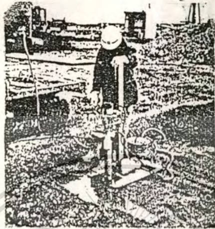
強度確認のためのコア採取 Core-collection for strength confirmation
