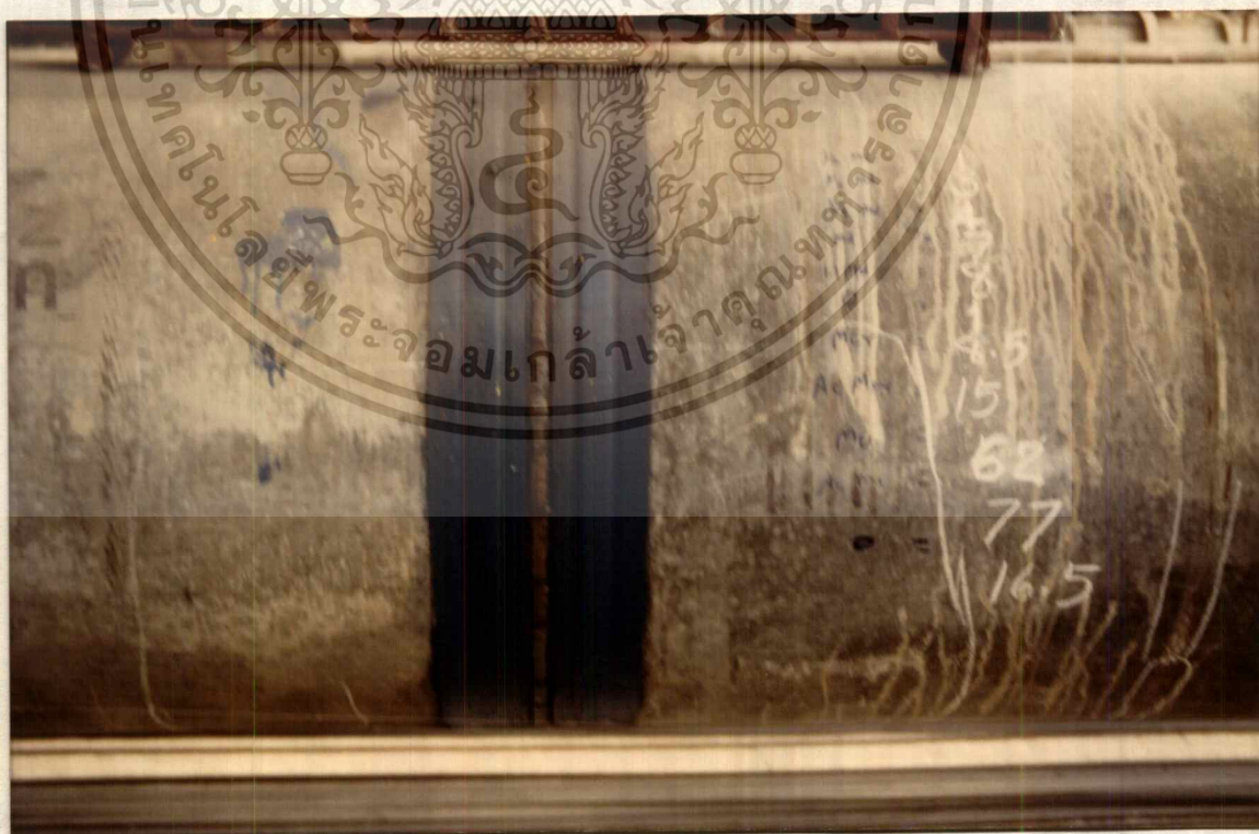
รูปที่ ผ-12 แสดงลักษณะการต่อเชื่อมของเสาเข็มที่ตีและคลื่นสามารถผ่านได้
