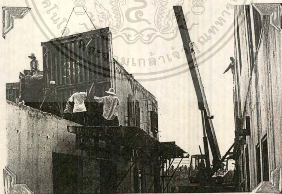
รูปที่ 8 แสดงการประกอบแบบในชั้นบน
