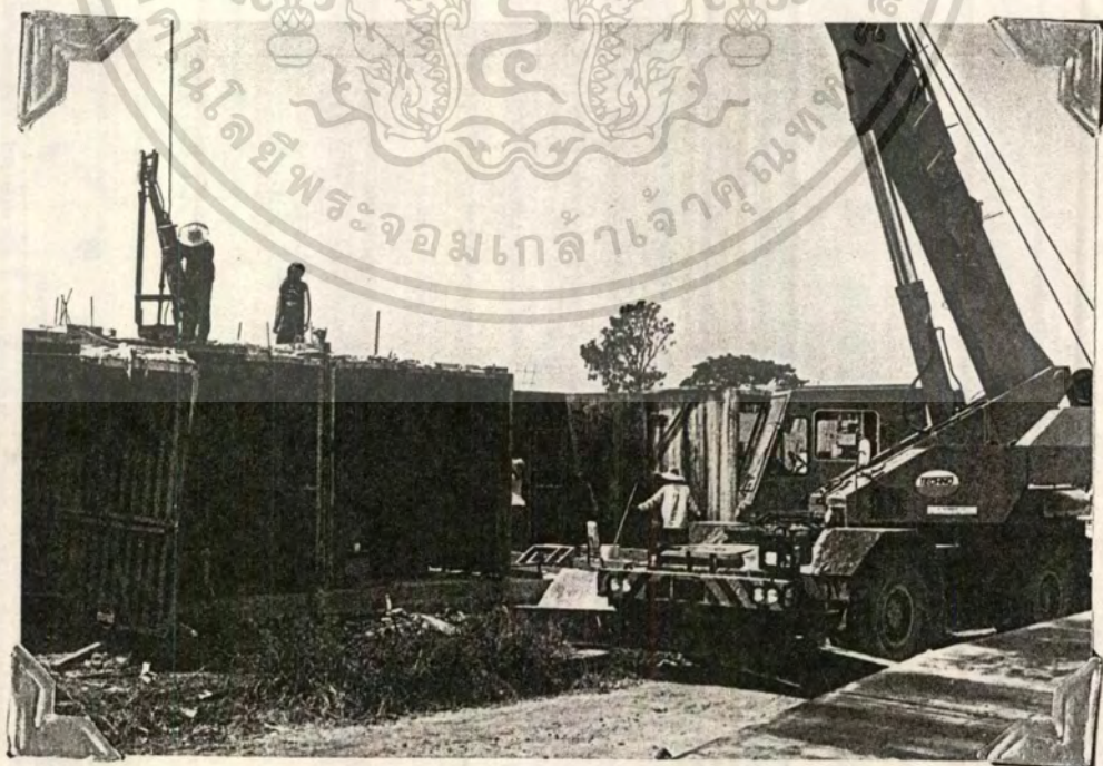
รูปที่ 4 แสดงขั้นตอนการยกแบบมาประกอบ
