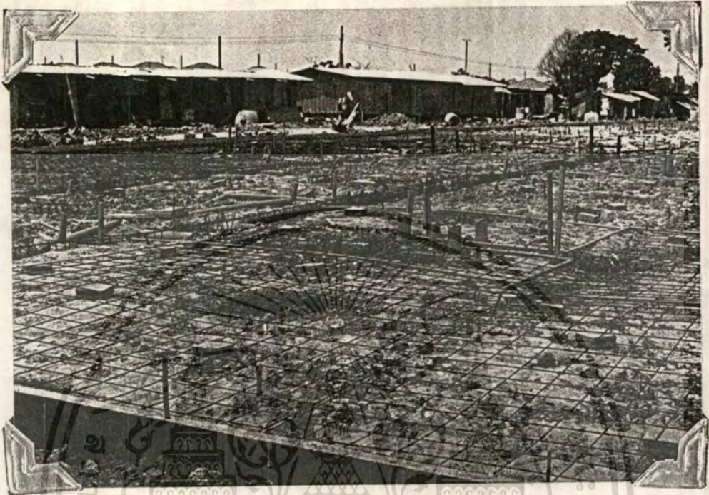
รูปที่ 1 แสดงการวางงานระบบในส่วนฐานราก
