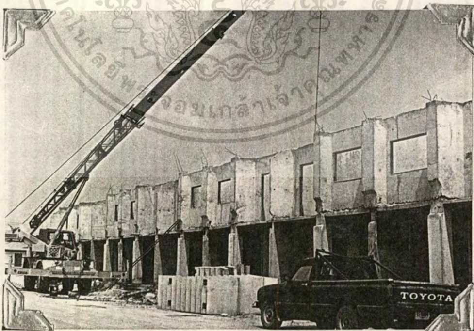
รูปที่ 14 แสดงสวนโครงสร้างที่แล้วเสร็จ
