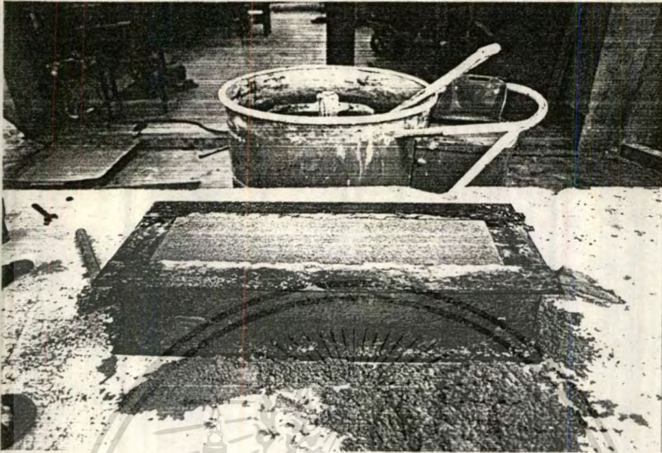
รูปที่ 3.7.9 รูปภายหลังจากใช้เกรียงปาดแต่งผิวให้เรียบ
