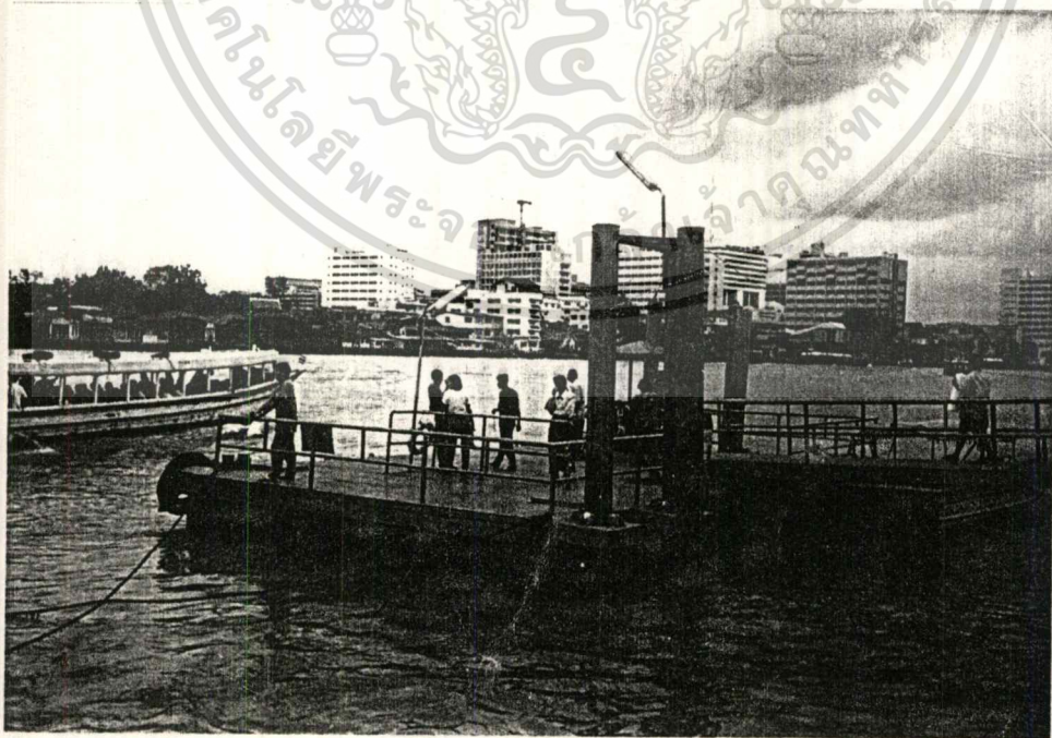
รูปที่ 33 แสดงลักษณะของพื้นเหล็กวางบนเรือ
