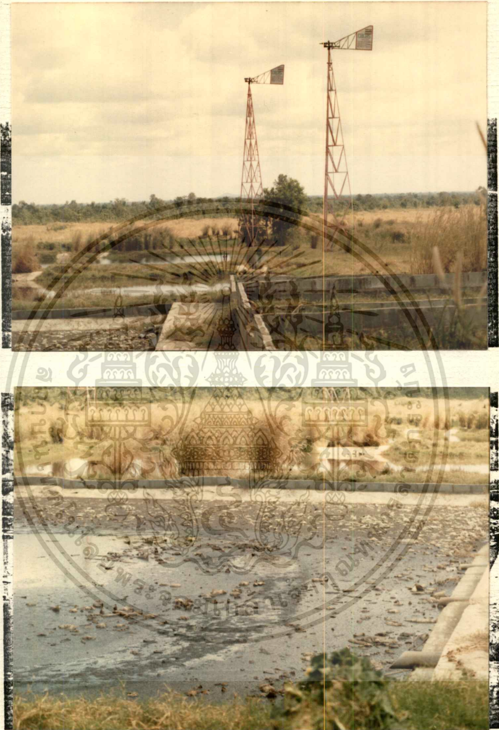
รูปที่ ๘๖ บ่อผันสภาพที่ใช้ในการกำจัดน้ำโสโครก ของศูนย์ ฯ เขาวีค่าน
