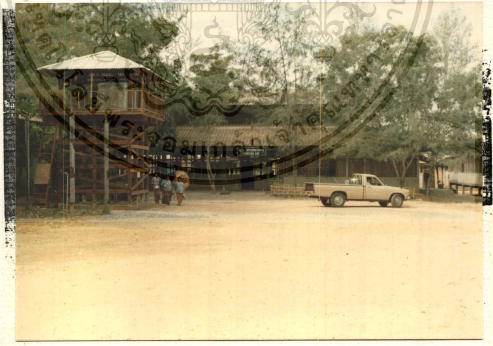
รูปที่ 18 ถังจ่ายน้ำแก่หน่วยงาน และ โรงพยาบาลภายในศูนย์
