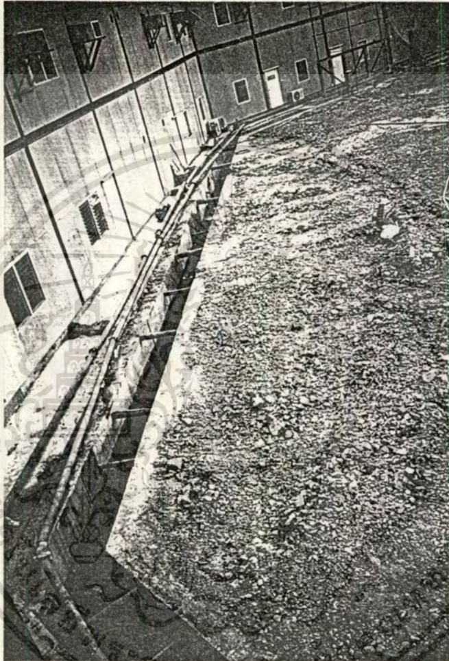
4. แสดงภาพประกอบหลังดำเนินการเทคอนกรีต Guide wall เสร็จเรียบร้อยแล้ว
