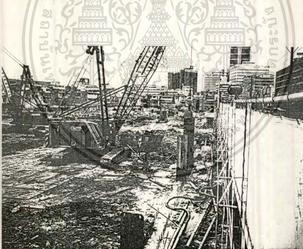
6. แสดงภาพประกอบการดำเนินงานขุดดินเพื่อทำ Diaphragm wall
