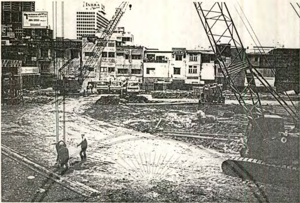
15. แสดงภาพประกอบการดำเนินงานติดตั้ง Water stop กับเหล็กกันระหว่าง Panel
