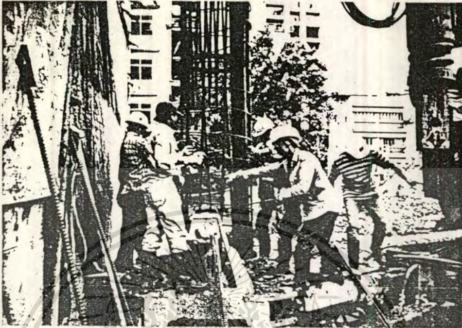
12. แสดงภาพประกอบการยกเหล็กเสริม secant pile wall ลงในหลุมเจาะ
