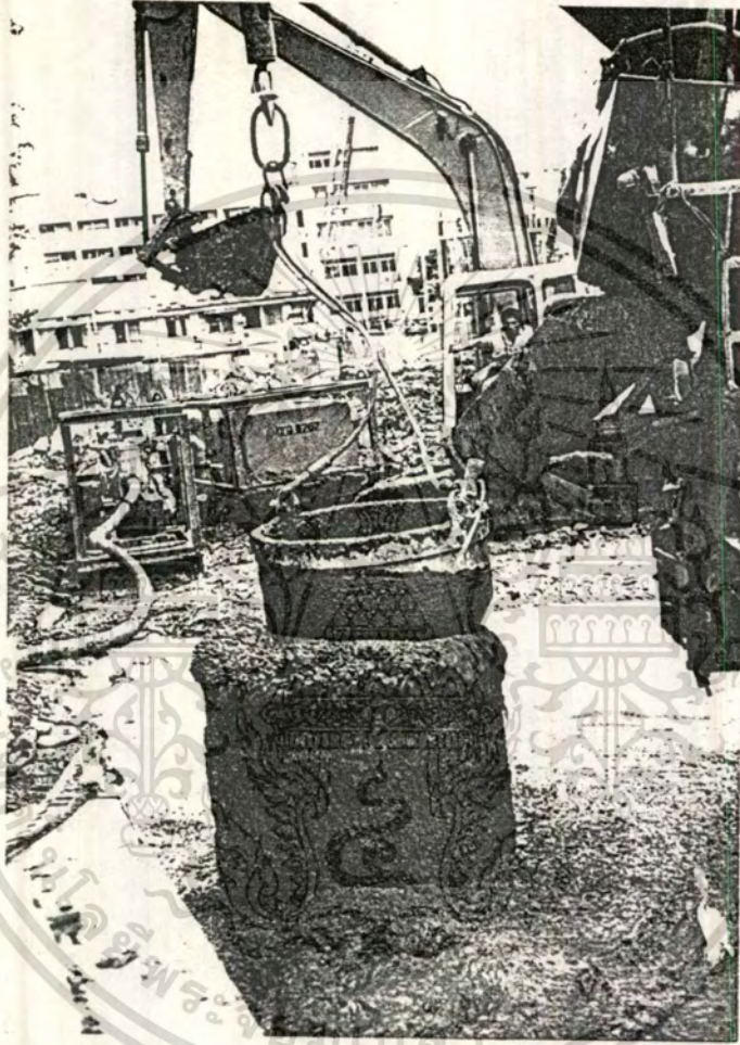
16. แสดงภาพประกอบการเทคอนกรีตจนกระทั่งคอนกรีตได้ขึ้นมาจากปากหลุมแล้ว
