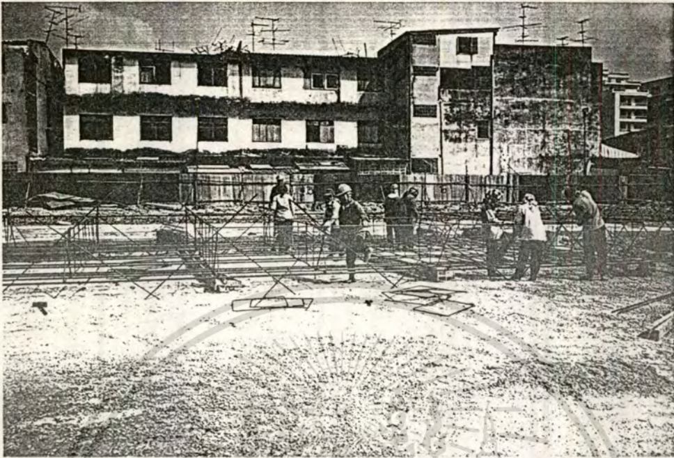
13. แสดงภาพประกอบการดำเนินงานเตรียมงานเหล็กเสริม Diaphragm wall
