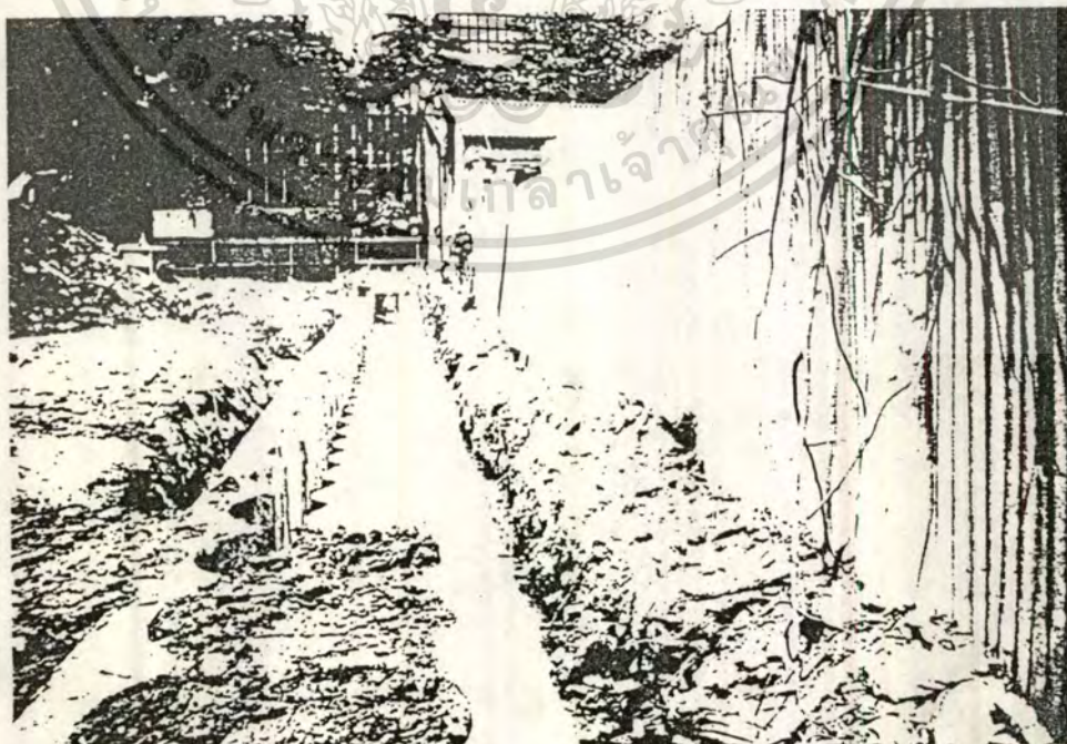
2. แสดงภาพประกอบหลังดำเนินการเทคอนกรีต Guide wall เสร็จเรียบร้อย
