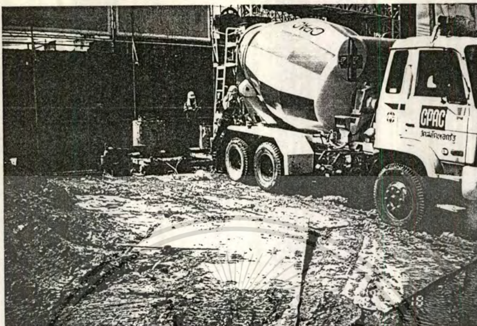
19. งานเทคอนกรีต Diaphragm wall
