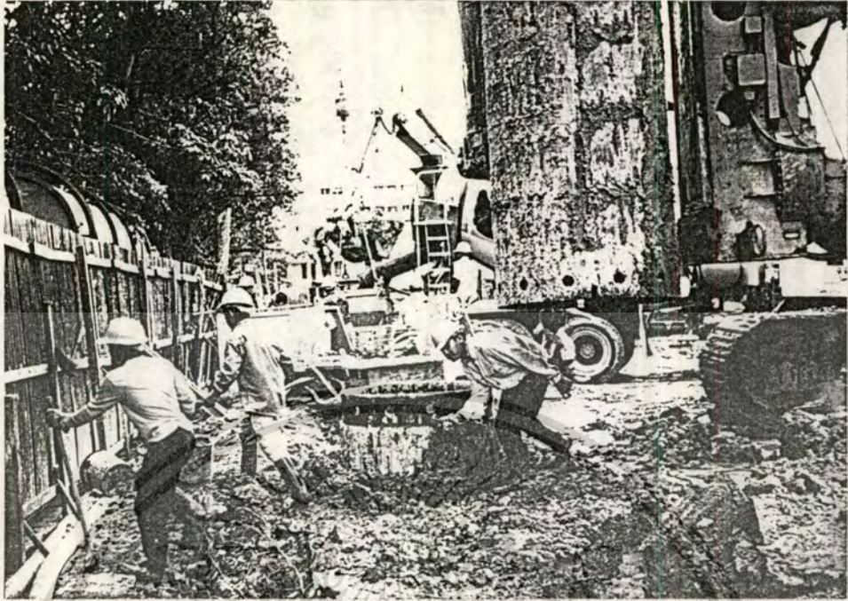
4. แสดงภาพประกอบการกวดเหล็กปลอกลงในหลุมของเข็มเจาะซีแคนท์
