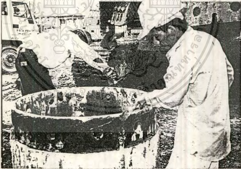
4.1 แสดงภาพประกอบการทาสีตรงรอยต่อของเหล็กปลอกเพื่อให้หล่อลื่นสวมง่าย
