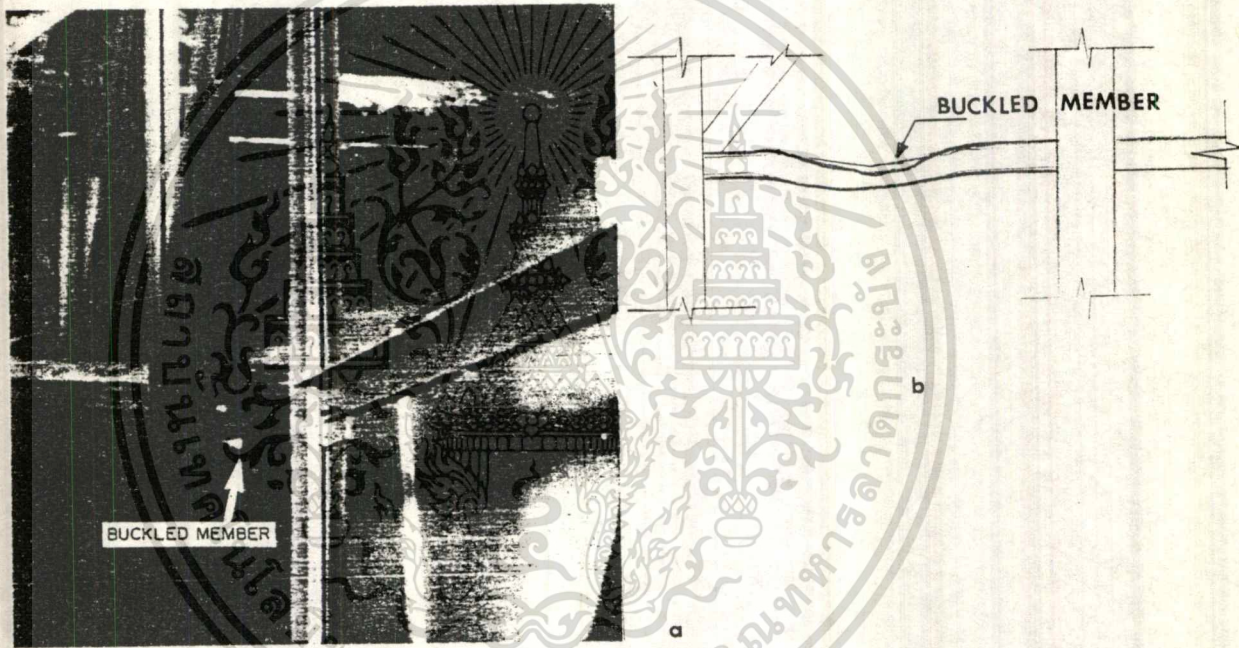
รูปที่ 2.3.21 (a) ส่วนของโครงเหล็กที่เกิดการโก่งงอของ Nassau Coliseum (b)ลักษณะของการ buckling
