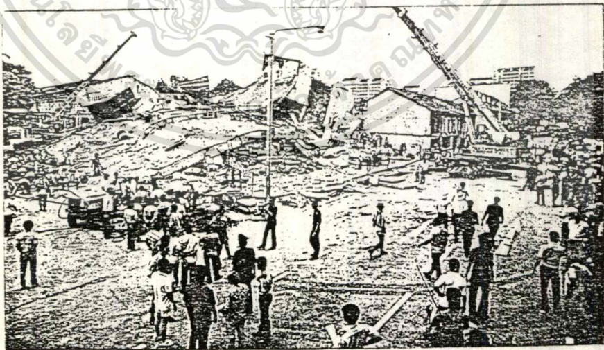
รูปที่ 2.2.56 แสดงให้เห็นสภาพของอาคารหลังการพังทลายในเช้าวันที่ 15 มีนาคม 2529
