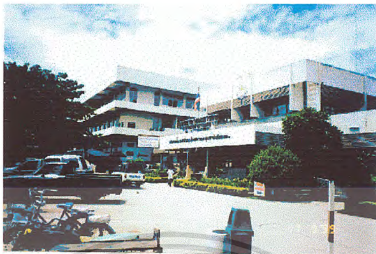
ภาพที่ 3.1.3 ภาพทางสัญจรด้านหน้าอาคารเดิมก่อนรื้อถอน
