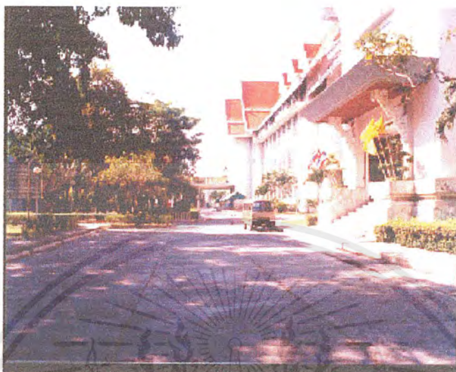
ภาพที่ 54 แสดงพื้นที่ข้างเคียงด้านทิศใต้ของโครงการ (อาคารหอสมุดแห่งชาติ)
