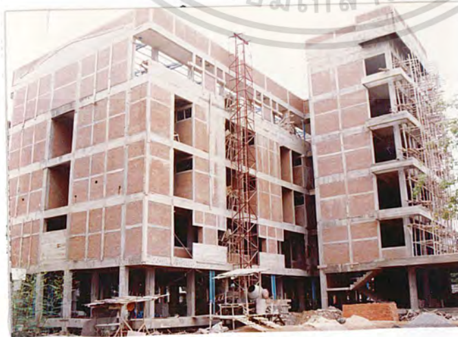
ภาพที่ 4.1.11 อาคารเอนกประสงค์ด้านทิศตะวันตก
