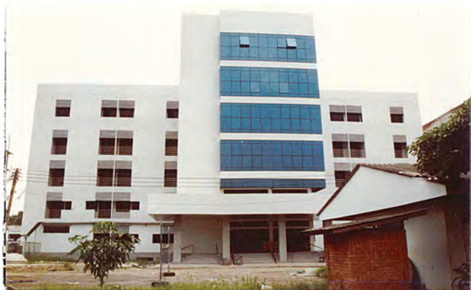
ภาพที่ 4.1.14 บริเวณด้านหน้าอาคารทางทิศเหนือ
