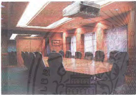
ภาพที่ 2.31 แสดงแหล่งกำเนิดแสงสว่างบนเพดานแบบระบบเพดานรวม
