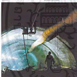
การใช้แสงเลเซอร์ในการสร้างแนวการจุดเจาะอุโมงค์
