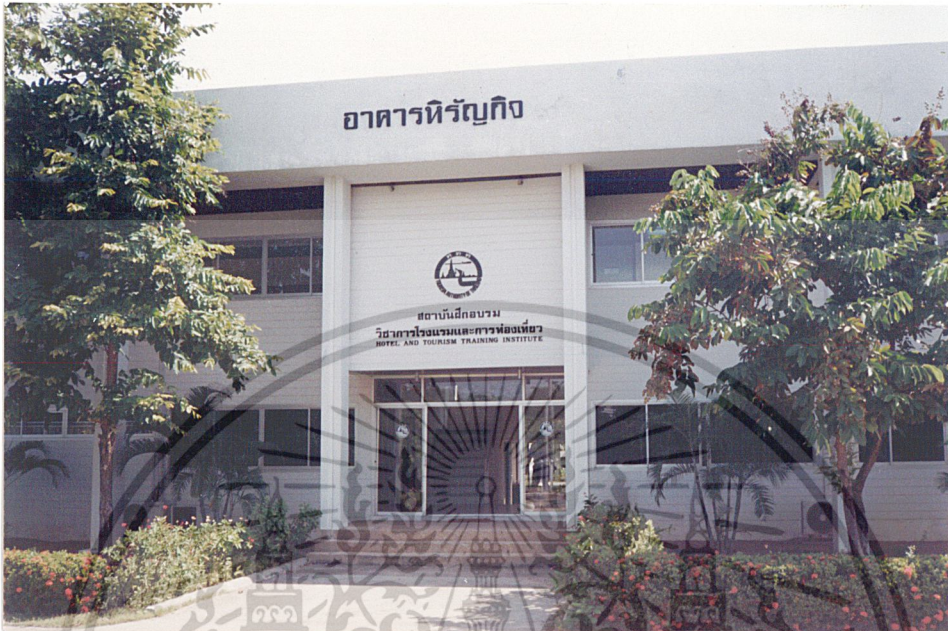
รูปที่ 3.3 อาคารอำนวยการ สรท.
