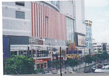
โครงการตึกข้างบริเวณสี่แยกรัชโยธิน
