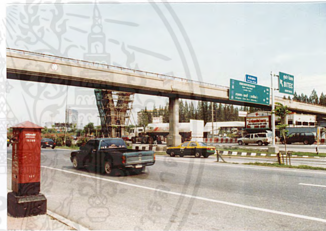
ภาพแสดงสภาพถนนบางนา-ตราดบริเวณหน้าโครงการซึ่ง กว้าง 10 ช่องทางจราจรและแบ่งเป็นสายในและสายนอก
