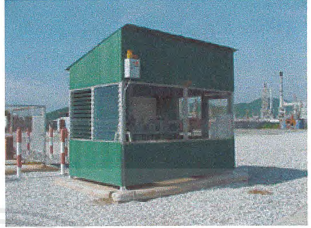
รูปที่ 35 แสดงภาพห้องควบคุมที่กระจายอยู่ตามจุดต่าง ๆ
