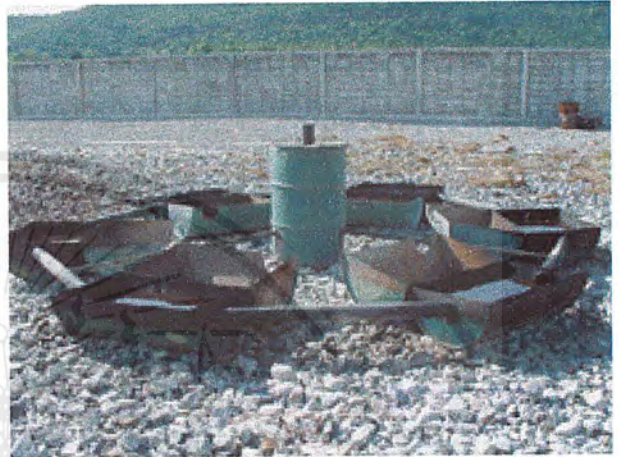
รูปที่ 25 แสดงการเก็บน้ำมันไว้ในภาชนะ แบบ CAROUSEL
