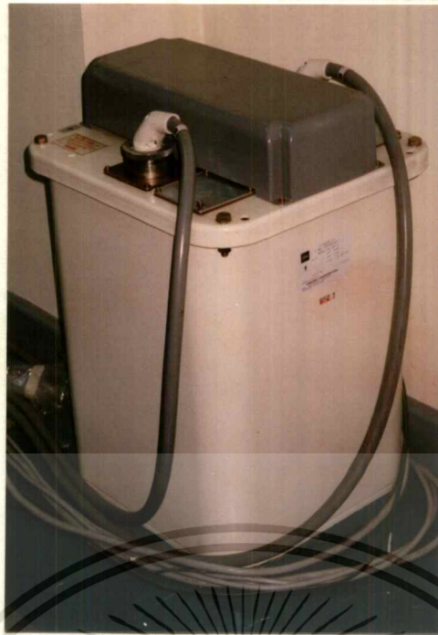
รูปที่ 4.12(ก) หม้อแปลงแรงดันไฟฟ้าสูง
