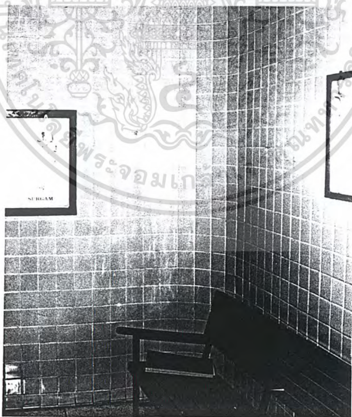
20. ลักษณะตรมห้องซึ่งทำเป็นลักษณะโค้งเพื่อสะดวกในการทำแผล พบได้ทั่วไปใน ร.พ.
