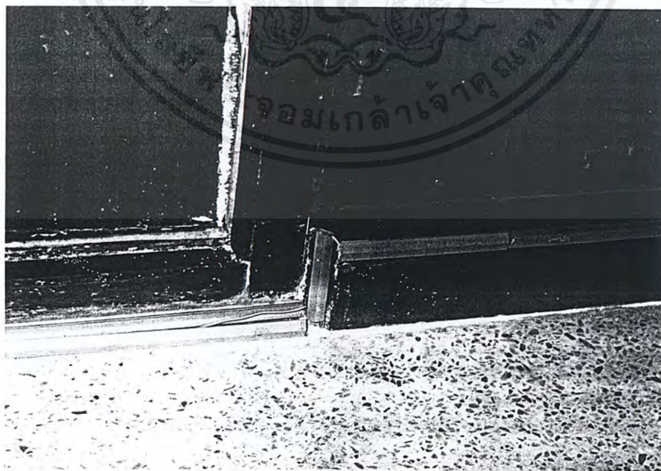
เอกรูปที่ 21. รอบๆห้องตรวจวัดการได้ยินจะมีการเดินสาย Loop System เพื่อเพิ่มประสิทธิภาพการการคำนวณค่าไม่ว่ากรณีใด ทำงานของเครื่อง Audiometer เนื้อหาและต้องอ้างอิงถึงเจ้าของเอกสารทุกครั้งที่มีการนำไปใช้
