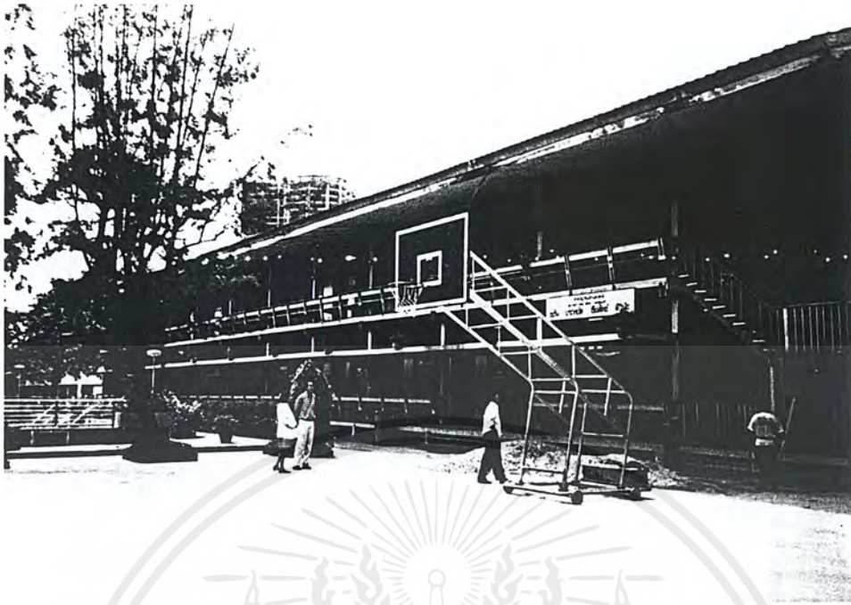
รูปที่ 3. อาคารเรียนเด็กประถมและอนุบาล ซึ่งมีอายุการใช้งานมากแล้ว สภาพอาคารในปัจจุบันต้องซ่อมแซมที่ปลายเหตุ เนื่องจากปลวกกิน ไม้ทั้งไม้สามารถทุบทิ้งเพื่อสร้างอาคารใหม่ได้ เพราะต้องการเก็บเป็นอาคารอนุรักษ์ของโรงเรียน
