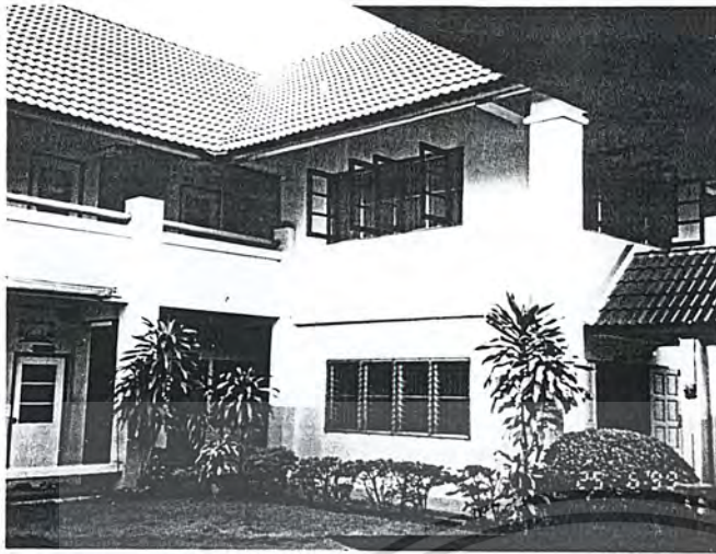
รูปภาพที่ 8.1.2 / 1 แสดง บริเวณ อาคารสำนักงาน ซึ่งใช้ Court ร่วมกับ อาคารเลี้ยงเด็กเล็ก
