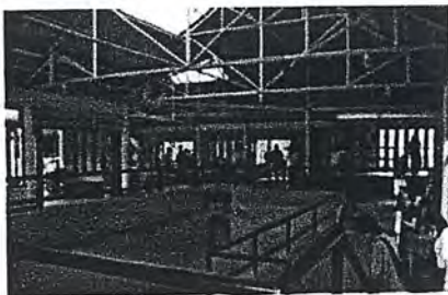
ภาพที่ 73 ในส่วนของอาคารอนุรักษ์เตาทุเรียง ได้นำโครงสร้างเหล็กระบบโครงถักมาประยุกต์ใช้เพื่อคลุมพื้นที่บริเวณกว้าง โครงหลังคาเหล็กให้ความรู้สึกที่เบาลอยตัว เกิด SPACE ที่โปร่งโล่ง
