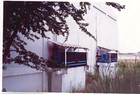
ส่วนระบายความร้อนของเครื่องปรับอากาศห้องเก็บฟิล์ม
