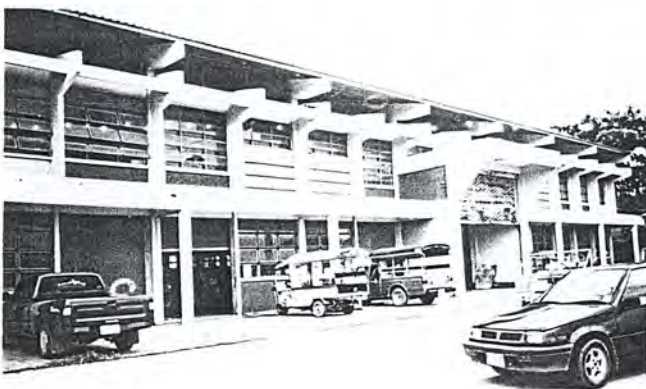
อาคารสถานีหน่วยจ่ายน้ำบาดาล
