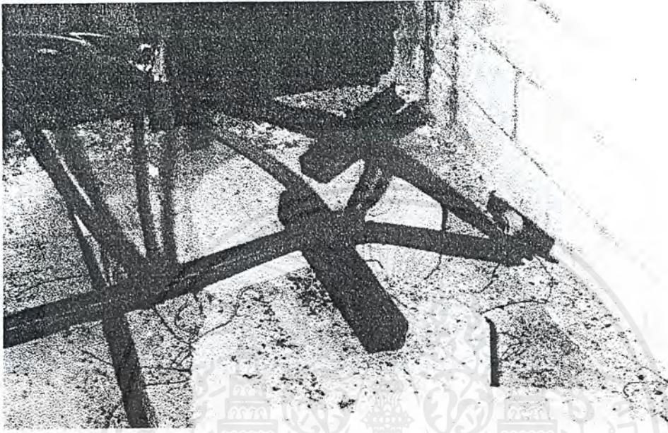
รูป ผ.ช.13. แสดงจุดวิบัติของโครงหลังคาองค์ประกอบเดียว
