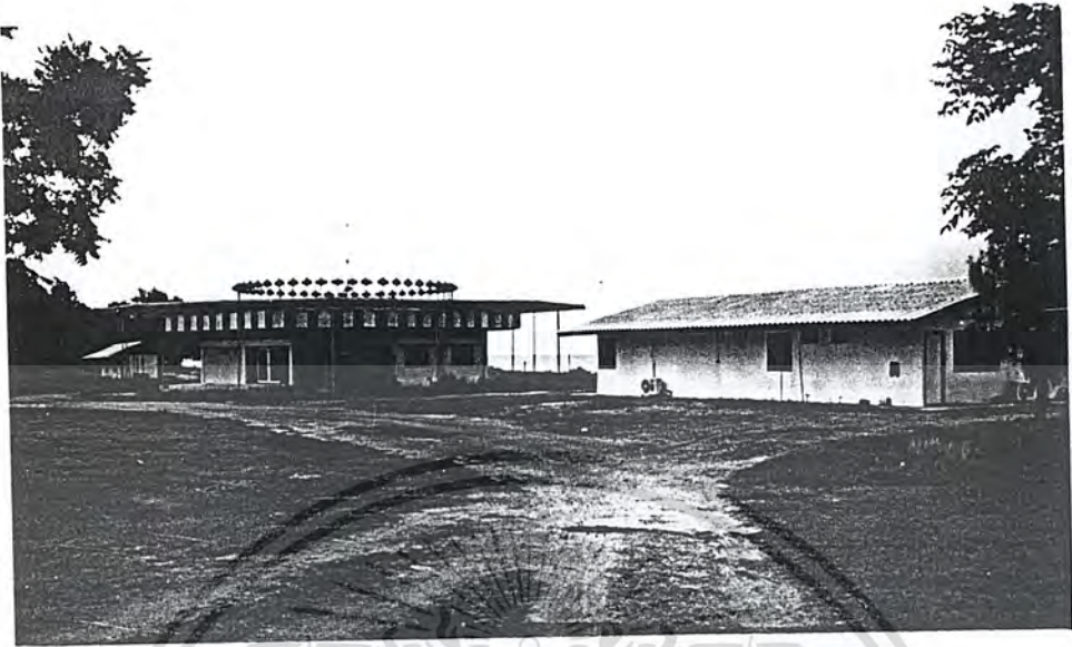
ภาพที่ 1.4.2 - 5 อาคาร DVOR/DME ในตำแหน่งเดิม
