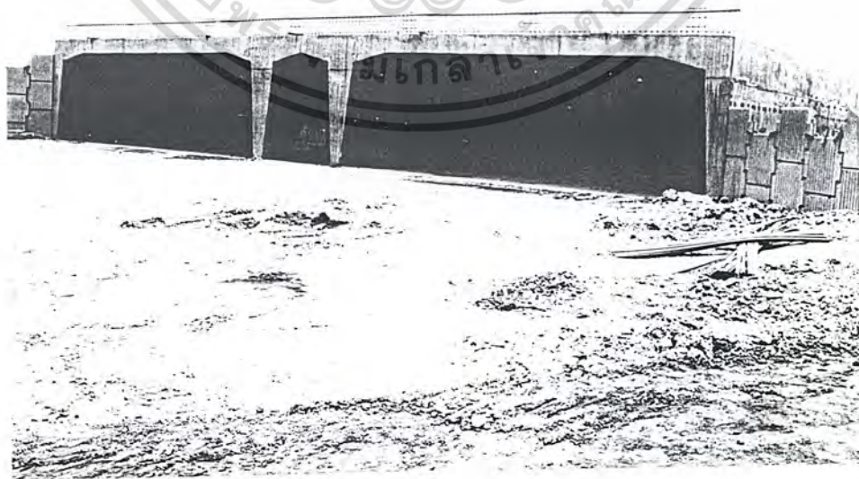
ภาพที่ 1.4.2 - 38 อุโมงค์ลอดทางวิ่งและทางวิ่งส่วนต่อเติม
