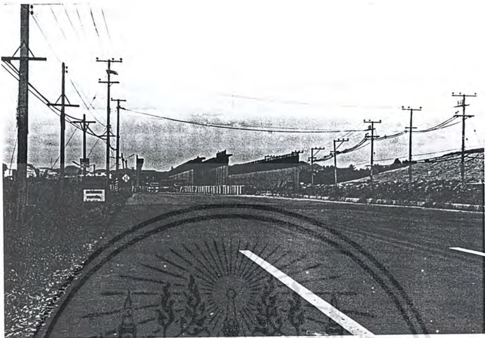
ภาพที่ 1.4.2 - 35 อุโมงค์ลอดทางวิ่งক্র่อมถนนเพชรเกษมและทางวิ่งส่วนต่อเติม
