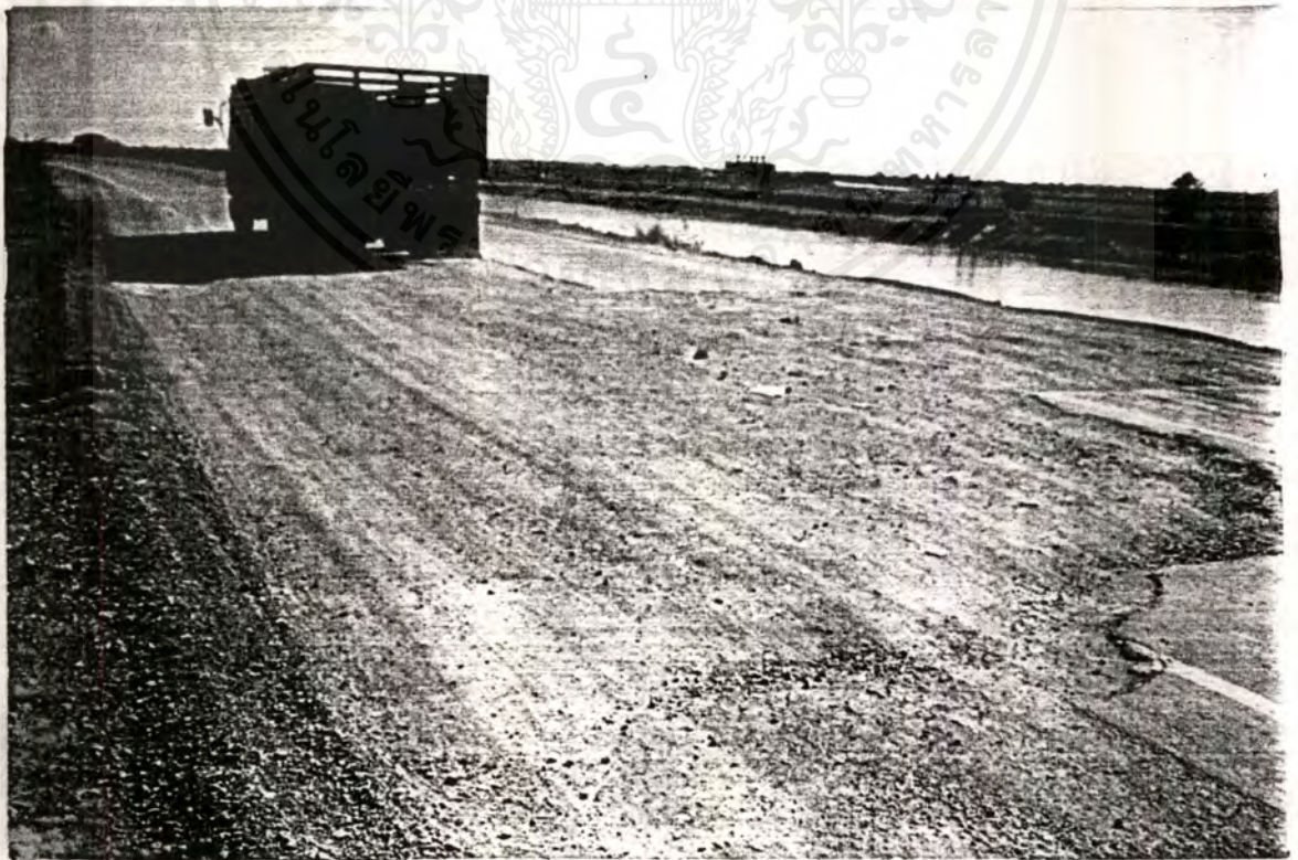
รูปที่ 7.5 แสดงลักษณะการชำรุดของถนนชลประทาน คลองส่งน้ำสายใหญ่ เนื่องจากรถบรรทุก
