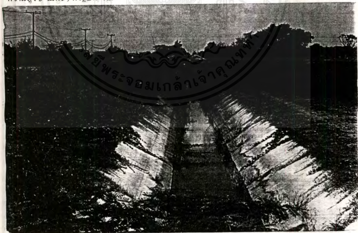
รูปที่ 7.2 ลักษณะถนนชลประทานแบบคลองส่งน้ำขนาดเล็ก ทางขาคือระดับดินเดิมและทาง
