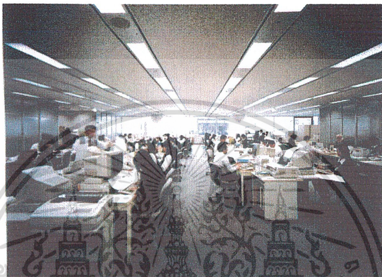
ภาพที่ 2.20 ลักษณะของการจัดวางดวงโคมแบบสมมาตรในสำนักงานทั่วไป
