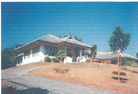
ภาพที่ 3.4.1 อาคารสำนักงาน
