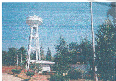
ภาพที่ 3.6.7 หอเก็บน้ำภายในอาคาร
