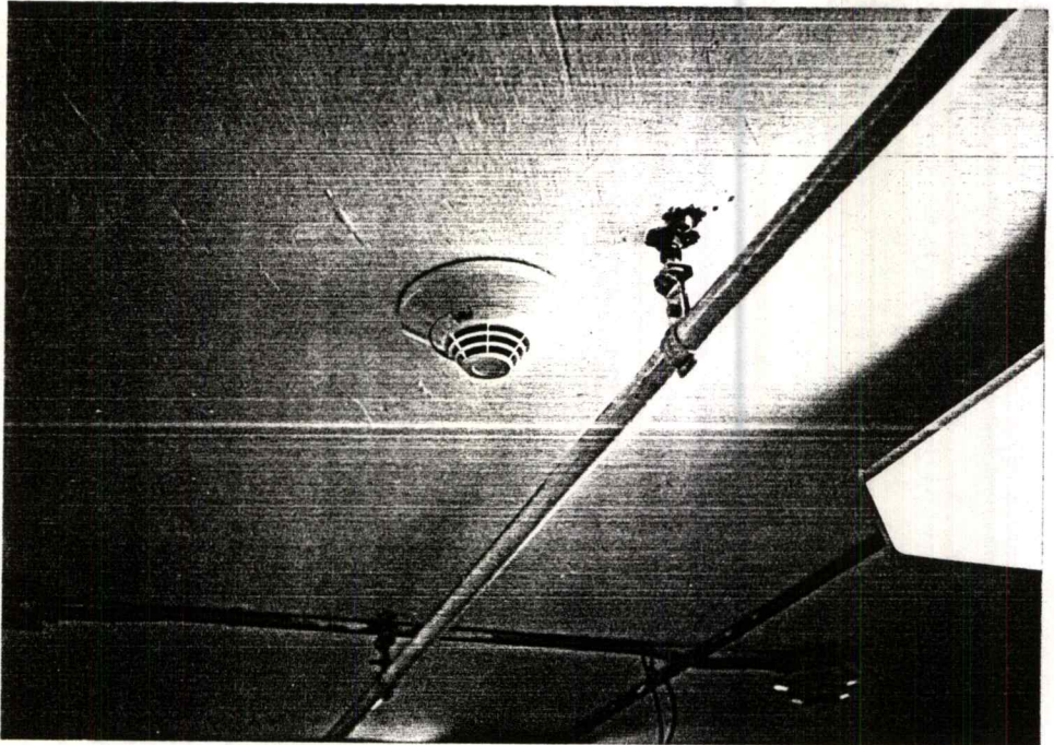
รูปที่ 1.10 แสดงอุปกรณ์ตรวจจับเพลิงไหม้ชนิด ตรวจจับควัน
