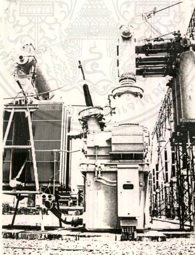
รูปที่ 3-22 การติดตั้งของชั้น-รีแอคเตอร์
