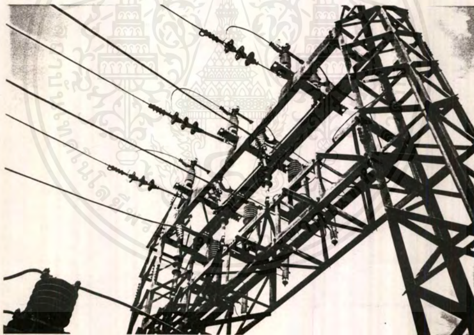
รูปที่ 3-28(ต่อ) การติดตั้งคิสคอนเนคติงสวิทช์อีกแบบหนึ่ง
